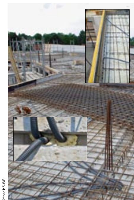
Bild 4: Verlegung der Leerrohre in der Stb.-Decke
