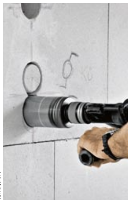
Bild 5: Bohren der Einbaudosen (Archivfoto)
