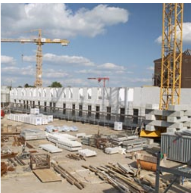
Bild 1: Verarbeitet werden ausschließlich Kalksandsteine des Markenverbundes KS-ORIGINAL: System KS-QUADRO für die Außen- und Innenwände sowie KS-QUADRO E für die Trennwände der Haftzellen.
