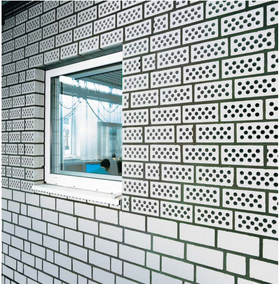
Bild 12: Schallschluckwand aus KS-Lochsteinen mit werkseitig durchstoßener Lochung
